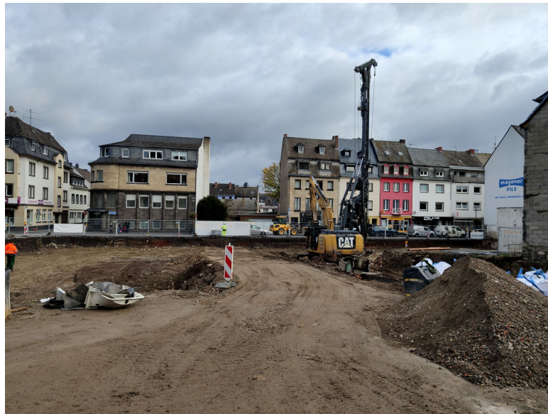
Baustelle 'Löwenkarree' (Foto: K.E. Lassau)
